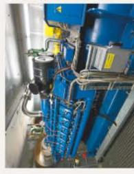
6 Blockheizkraftwerk
